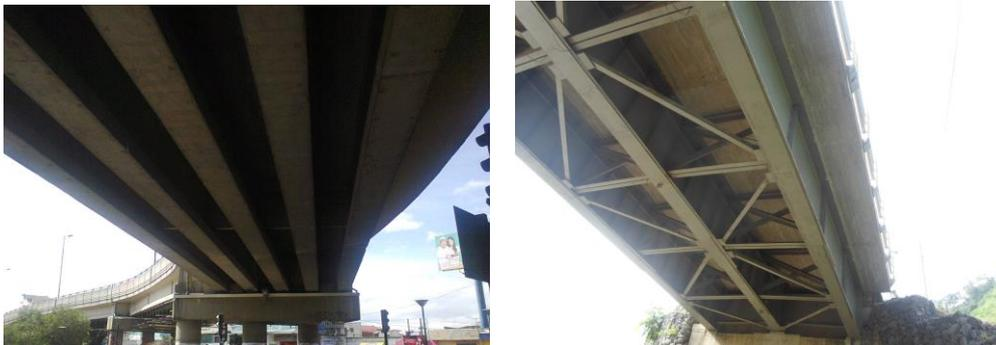
*Fig. 6.1a: Puentes con vigas presforzadas, y con vigas metálicas*
