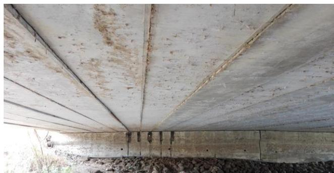
*Fig. 6.1b: Puentes con vigas-losas (I o tubo rectangular) presforzadas*
