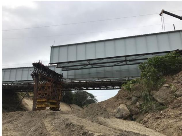
**Fig. 6.12: Montaje de vigas metálicas de puente**
