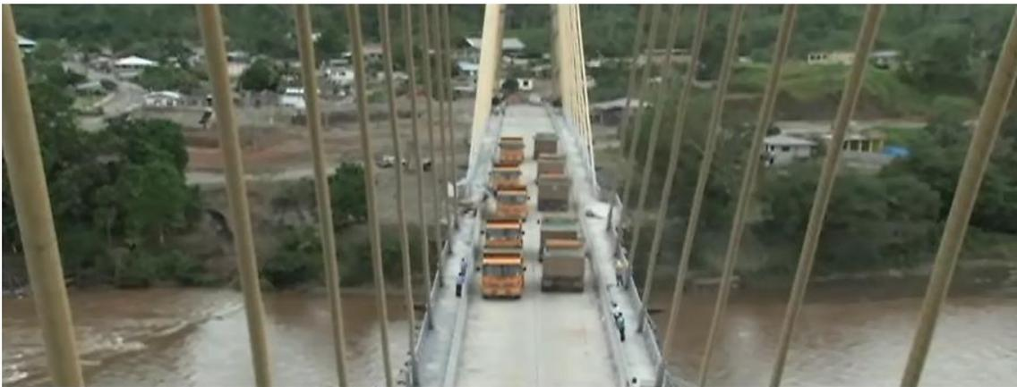
**Fig. 6.5:** *Dimensiones referenciales en la prueba de carga del Puente Aguarico, con camiones en movimiento*
