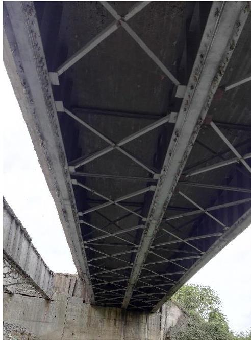
*Sistema de Arriostramiento en Celosía, en tableros con vigas metálicas:
