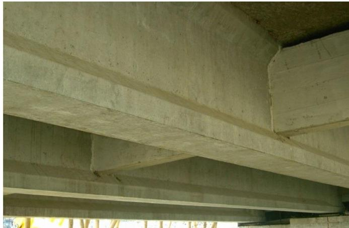
*Viga-diafragma Transversal, como sistema de arriostramiento de vigas longitudinales preesforzadas*
