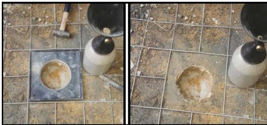
Imagen 28 Excavación para ensayo
