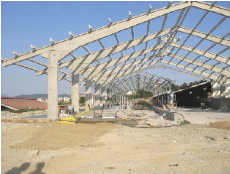
Fig. 3.3: Piezas prismáticas: diferentes secciones
