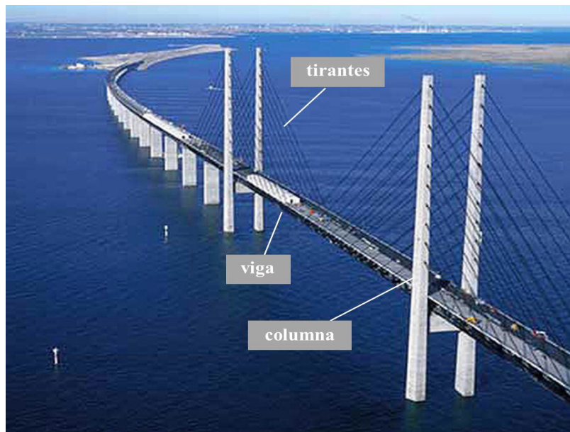
Fig. 3.8: Elementos estructurales: vigas, columnas y tirantes
