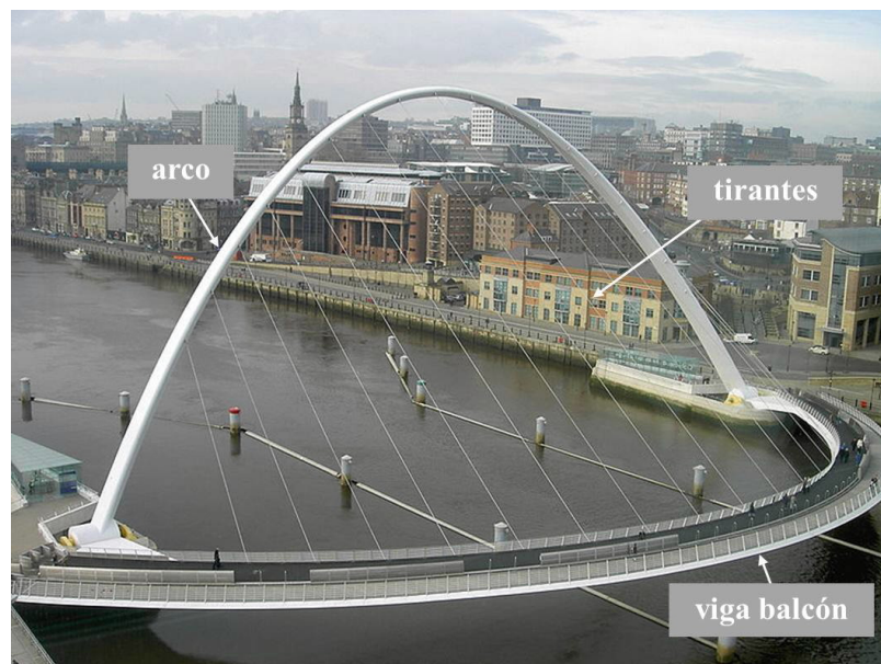
Fig. 3.9: Elementos estructurales: arco, tirantes y viga balcon
