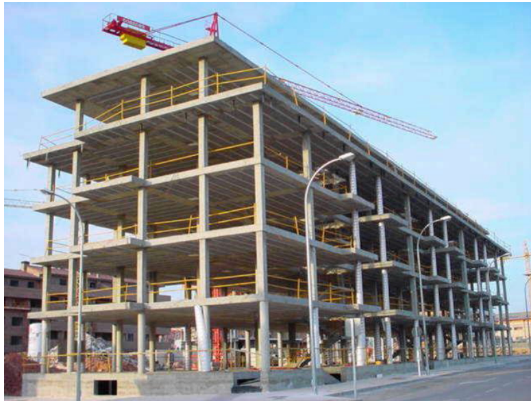
Fig. 1.11: Estructura reticulada espacial
