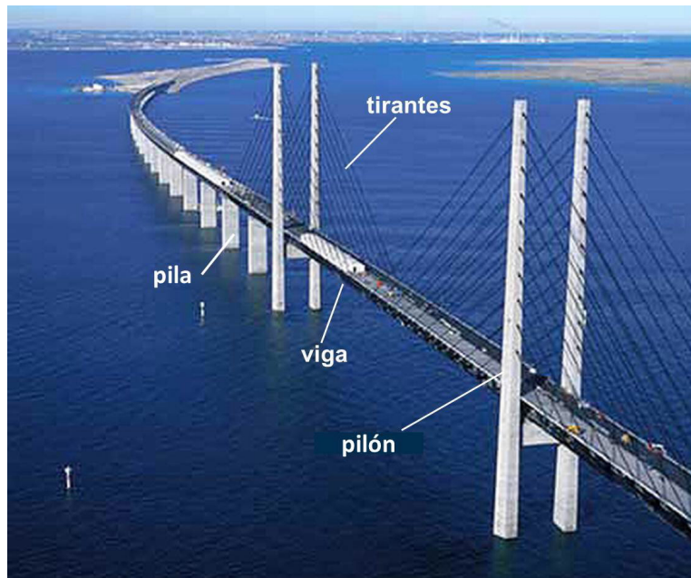
Fig. 1.5: Elementos estructurales básicos
