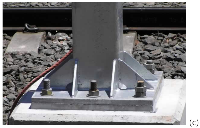
Fig. 1.7: Apoyos: (a) simple (b) fijo (c) empotramiento
