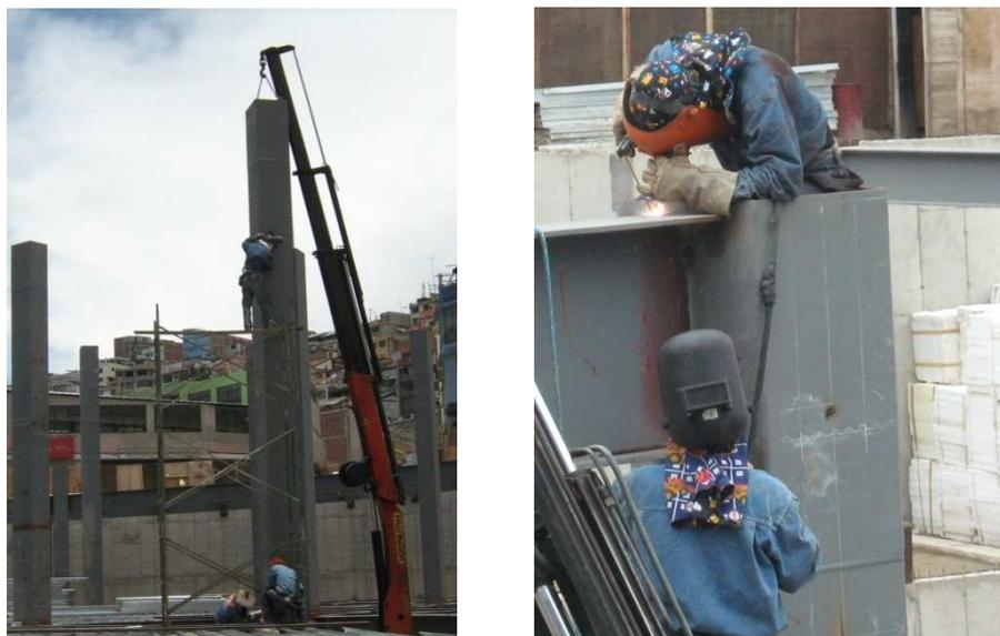
a) **Figura 5.22 a) Montaje de una columna, b) Punteados de una viga**
