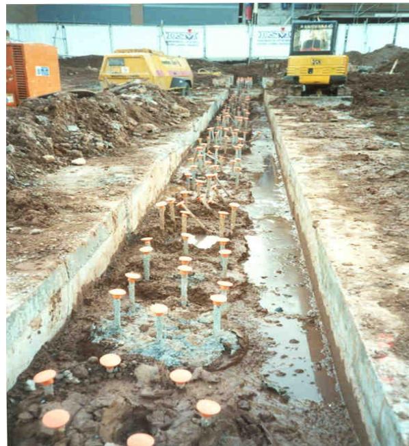
Fig 2.2, Utilización de brocal prefabricado, para la construcción de pilas secantes
