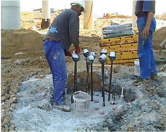
Fig 2.4 (cont.), Descabece de pilas con el sistema de inyección
