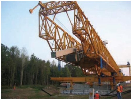
Fig 2.7 Armadura en posición; pilote y guías girando a posición vertical
