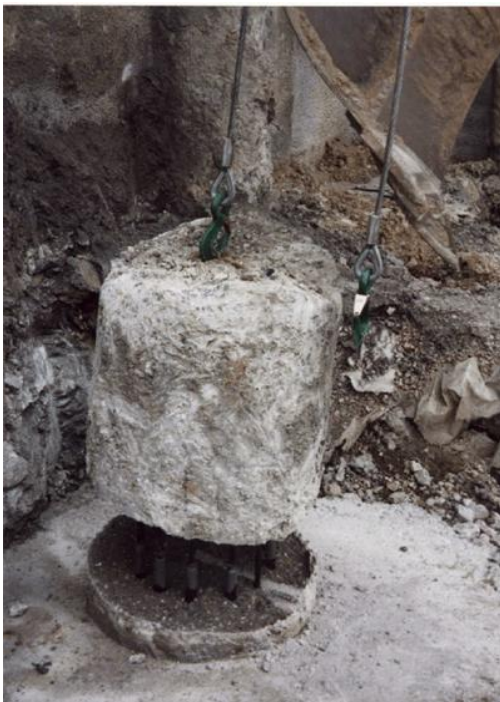
Fig 2.3, Descabece de pilas con el sistema de cuña
