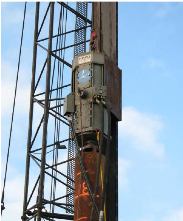
Fig 3.1, Martillo vibratorio resonante de 200 Hp y pilote de tubo de 60 cm de diámetro
