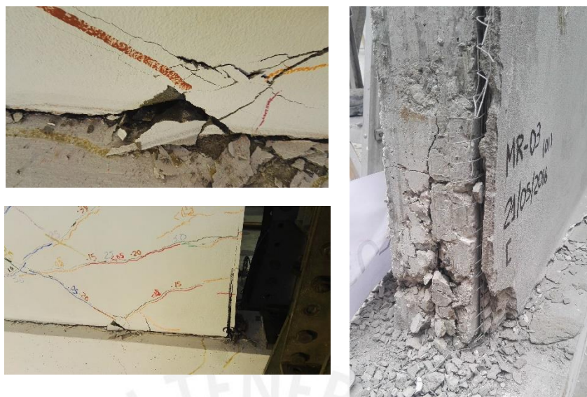
Figura 6.50. Estado final post-ensayo MDL03-R-SCA
