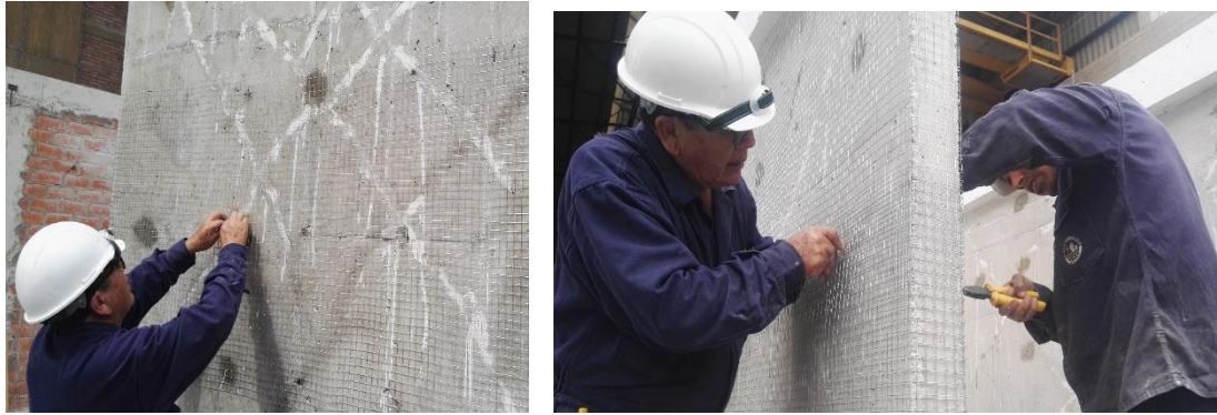
Figura 5.13. Colocación de la malla electrosoldada en el muro reparado.
