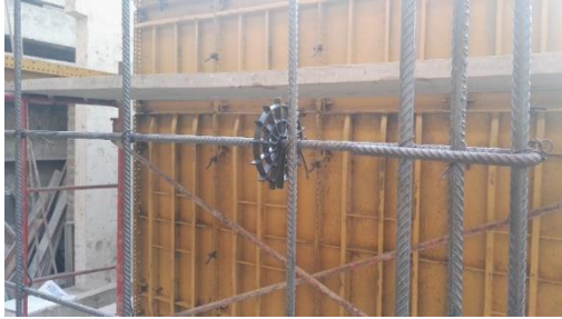
Figura 3.15. Separadores plásticos colocados en las hileras de acero.
