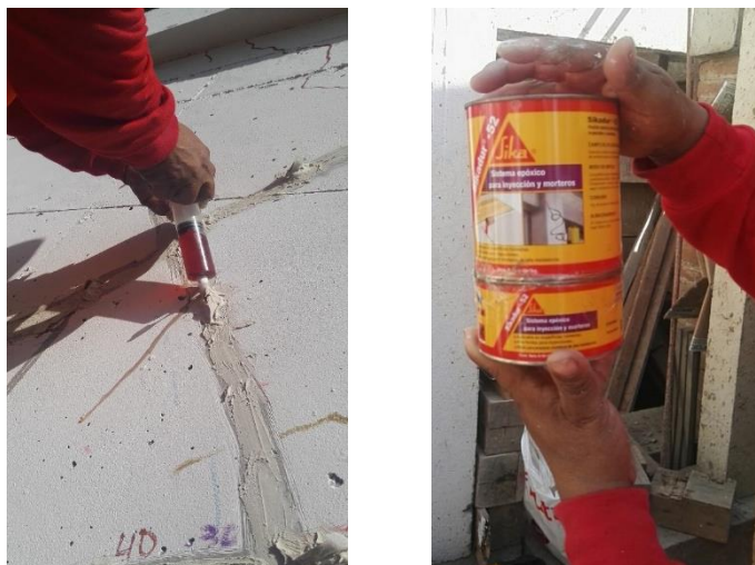
Figura 5.6. Inyección del epóxico SIKADUR-52.
