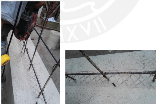
Figura 3.14. Perforaciones y colocación de las fijaciones interiores para encofrado metálico
