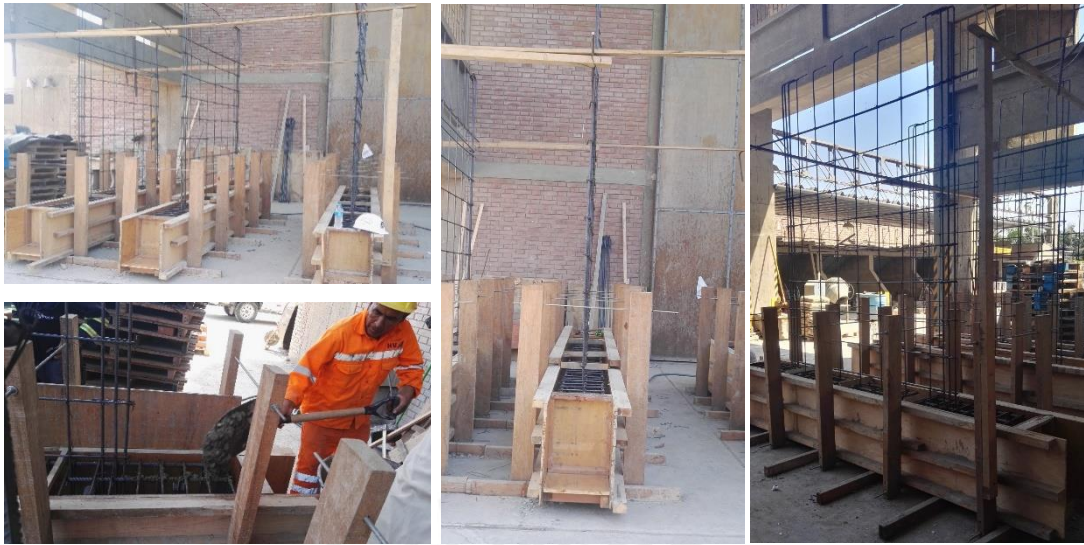
Figura 3.11. Refuerzo vertical acondicionado para el llenado de la viga de cimentación de los MDL.
