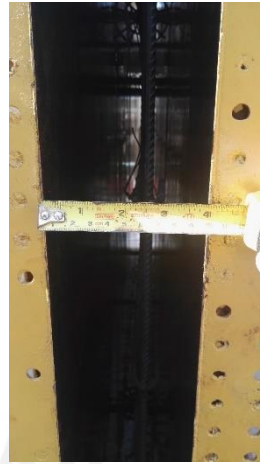
Figura 3.16. Encofrado metálico de 4" de espesor de muro.
