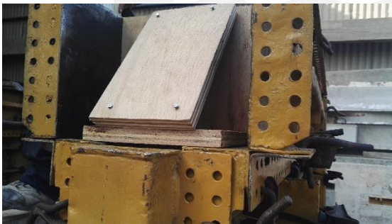
Figura 3.17. Encofrado de madera para la viga solera de los MDL.
