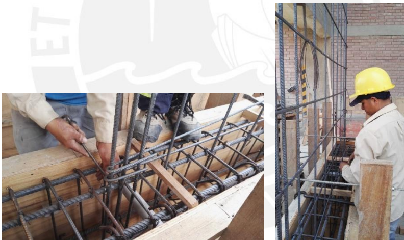
Figura 3.10. Armado del enmallado del muro de concreto anclado a la viga de cimentación.
