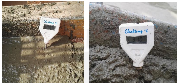
Figura 3.1. Medición de la temperatura para cada tanda de mezcla
