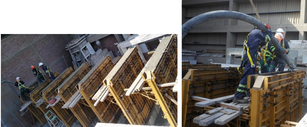
Figura 3.19. Llenado con concreto UNICON de los 09 MDL.
