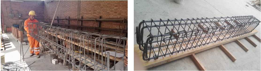
Figura 3.7. Habilidad de acero de refuerzo de vigas de cimentación
