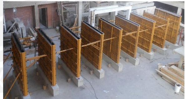
Figura 3.18. MDL encofrados y dispuestos para el llenado de concreto.
