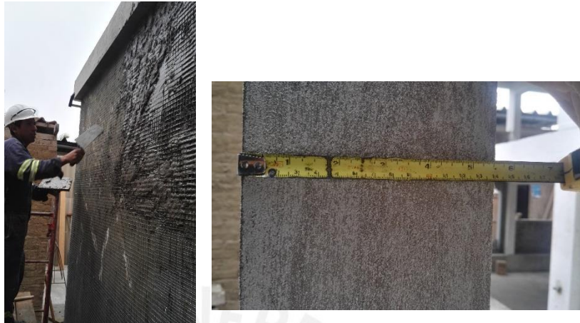
Figura 5.15. Aplicación de mortero al muro y espesor final del mismo.
