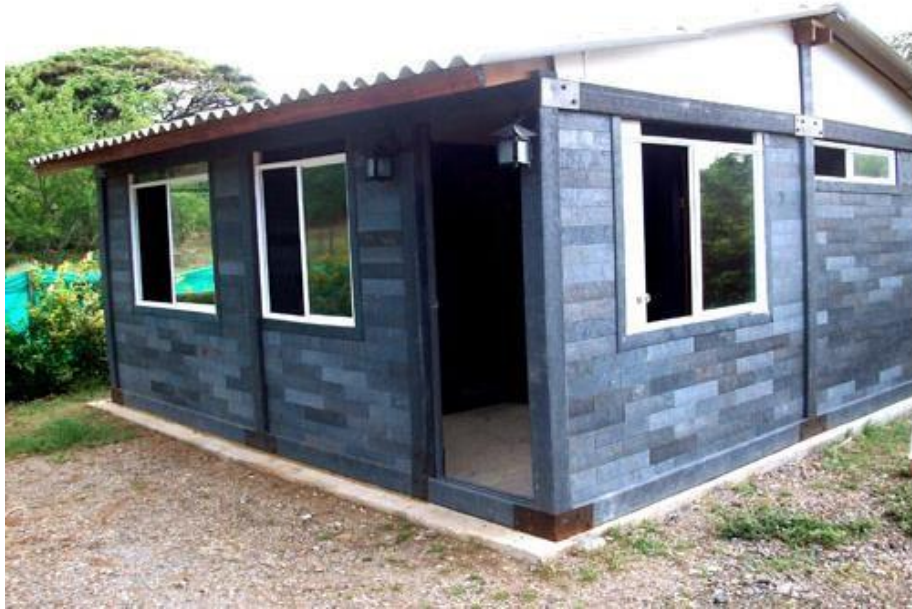
Vivienda construida con sistema constructivo Brickarp
