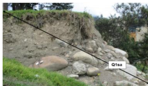
Figura 11. Composición y estructura de los suelos en inmediaciones al río Fucha. Fuente: [11].
