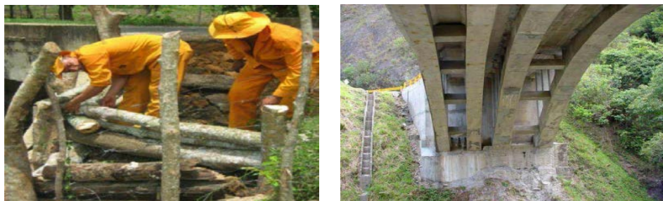
Figuras 1.16 y 1.17 Reparación de conos y taludes.
