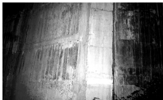
Figura 1.20. Pantalla de concreto como refuerzo en estribo.
