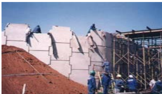
Figuras 1.10 y 1.11 Imágenes de dos macizos de tierra armada mostrando las escamas o paneles prefabricados en concreto y los flejes de hierro dulce galvanizado con los cuales se arma el suelo ubicado detrás de paramento. (Estribos).
