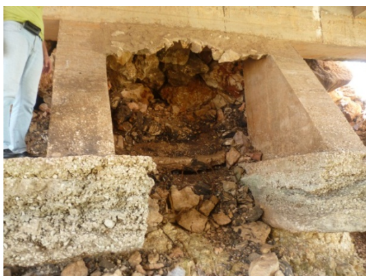
Figuras 2.4-2.5 Representación de las causas que provocan los daños en las losas de aleros.
