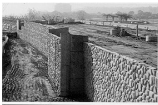
Figuras 1.12 y 1.13 Imágenes de los paneles rectangulares del sistema de tierra reforzada ARES® con geomallas Tensar® HDPE.
