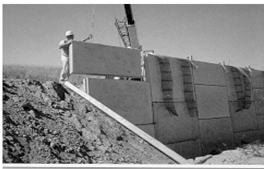
Figuras 1.12 y 1.13 Imágenes de los paneles rectangulares del sistema de tierra reforzada ARES® con geomallas Tensar® HDPE.
