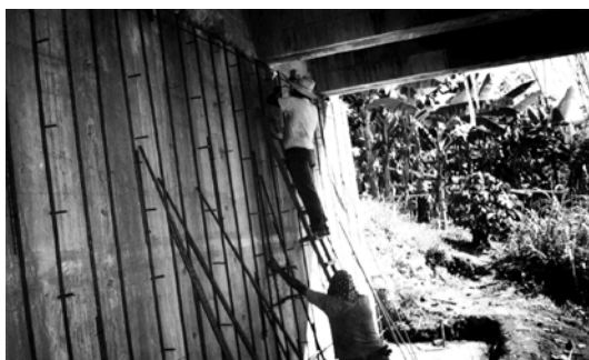
Figura 1.19. Encamisado estructural de estribo. Puente Río Negro.
