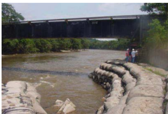
Figuras 1.23 y 1.24. Espolones de bolsacretos para protección. Puente Orito
