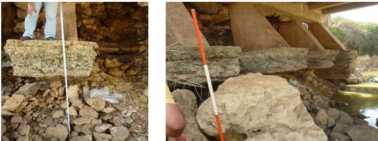
Figuras 2.25 – 2.26 Daños en la cimentación en estribo lado Aguadas.
