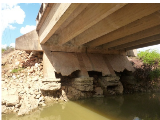
Figuras 2.4-2.5 Representación de las causas que provocan los daños en las losas de aleros.
