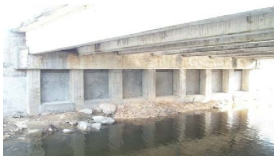
Figura 1.38. Solución de estribo cerrado.
