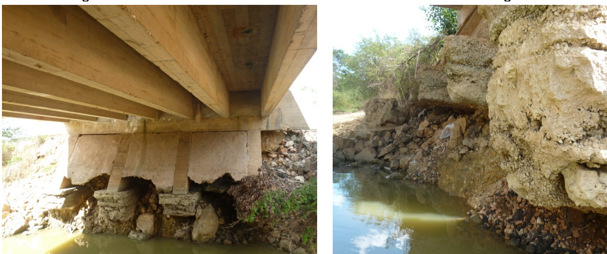
Figuras 2.25 – 2.26 Daños en la cimentación en estribo lado Aguadas.
