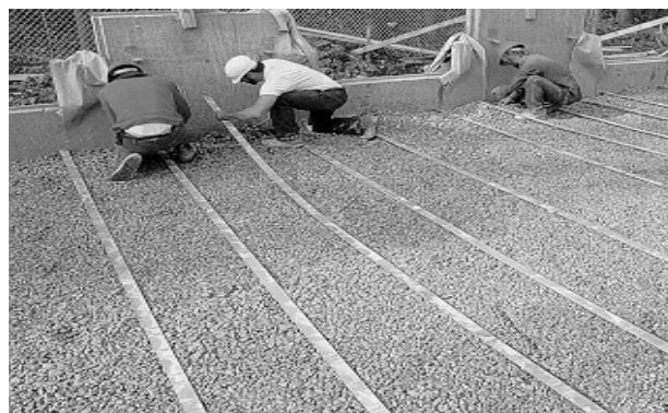
Figuras 1.10 y 1.11 Imágenes de dos macizos de tierra armada mostrando las escamas o paneles prefabricados en concreto y los flejes de hierro dulce galvanizado con los cuales se arma el suelo ubicado detrás de paramento. (Estribos).
