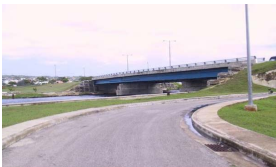
Figuras 1.32 y 1.33. Solución de muros tipo cribas.
