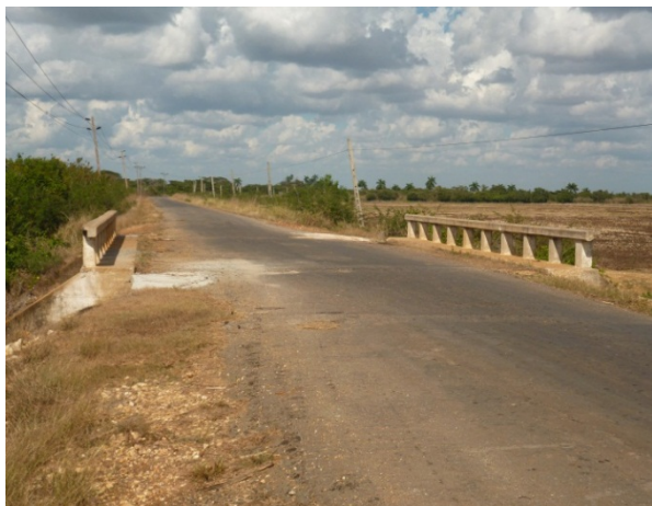
Figura 2.2 Vista general de la losa de alero en el puente.
