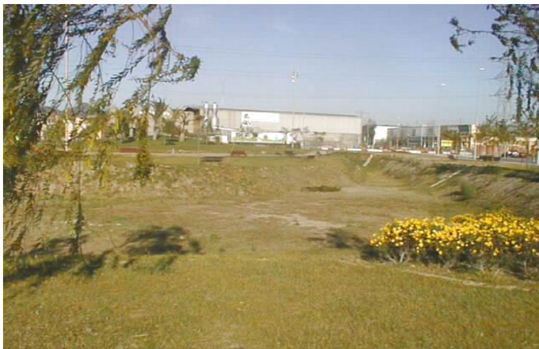
Figura 5: Depósitos de infiltración
