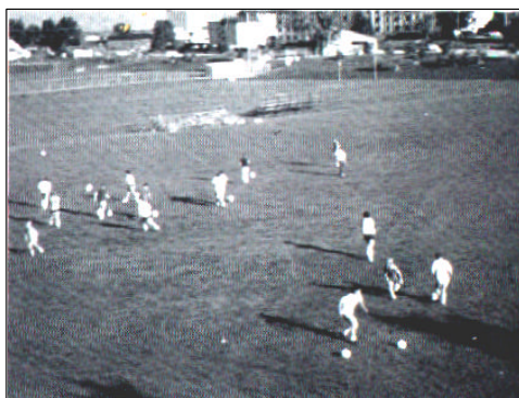
Figura 4: Depósito de retención con derivación, en Denver. Está siendo usado como campo deportivo en épocas de tiempo seco
