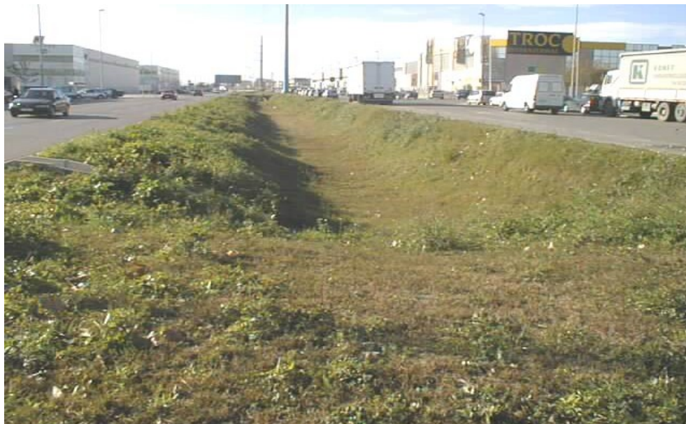
Figura 3: Cuneta filtrante. Sant Boi de Llobregat
