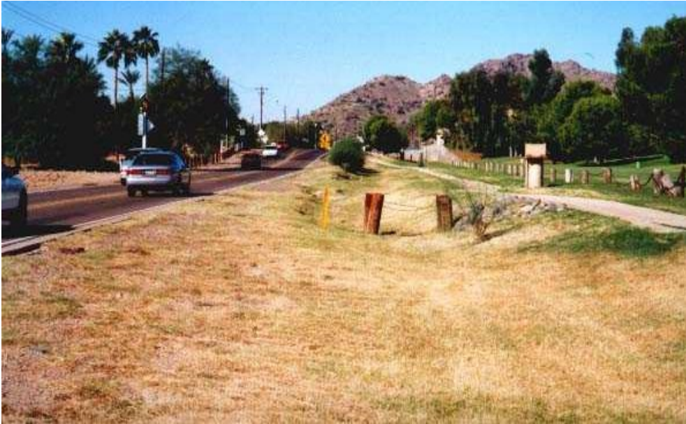
Figura 2: Cuneta filtrante (Phoenix AZ)
