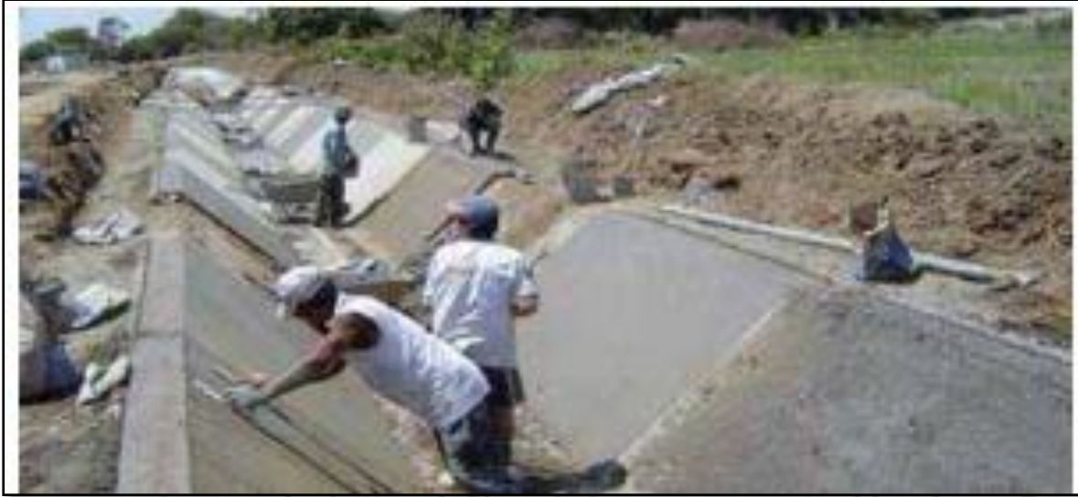
Figura 73 .ejecución de canal.
