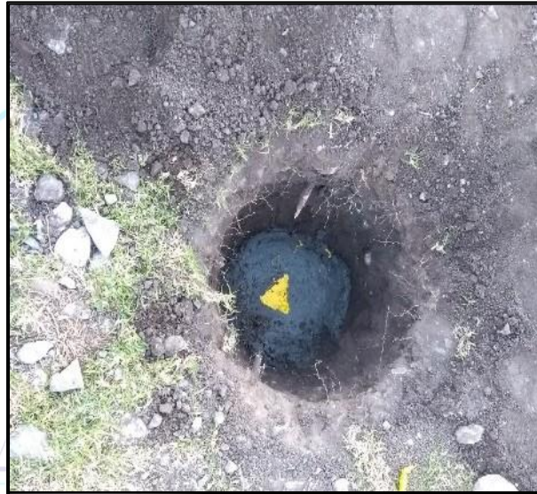
Figura 15. colocación de una plantilla.
