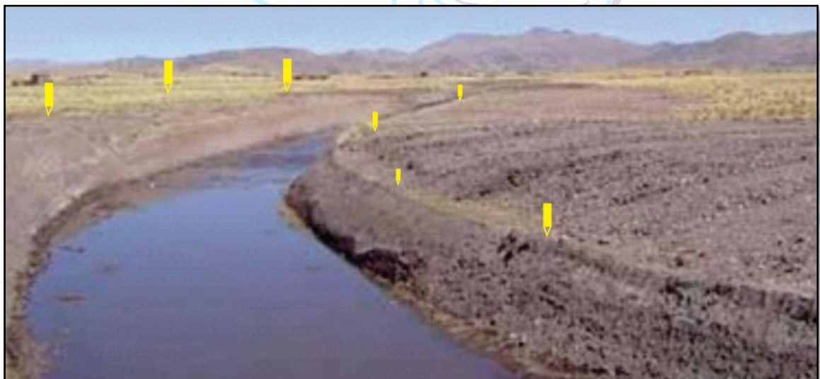
Figura 72 .plantillado para borde de canal.
