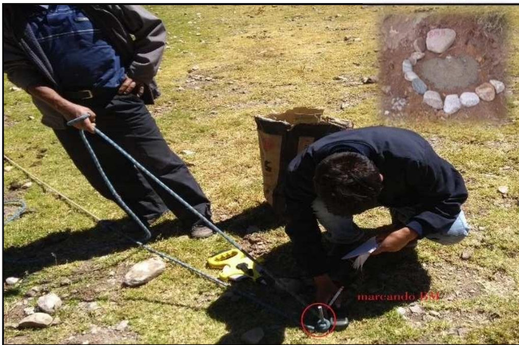
Figura 8. Forma de establece un Bm en un punto determinado.
