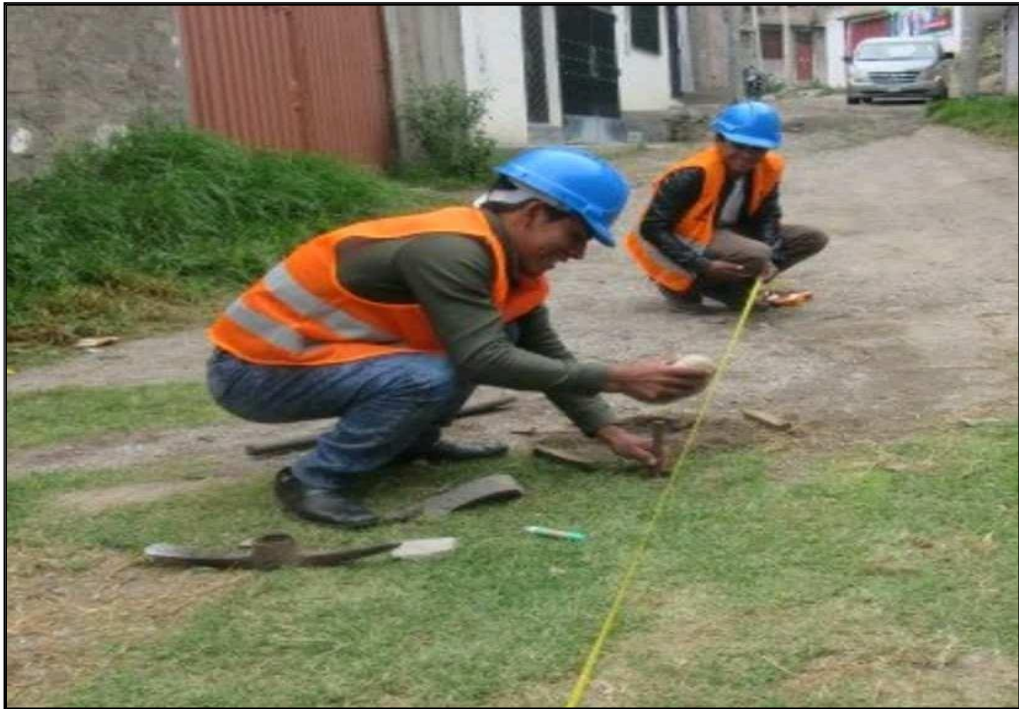
Figura 9. Medición de distancia entre progresivas.
