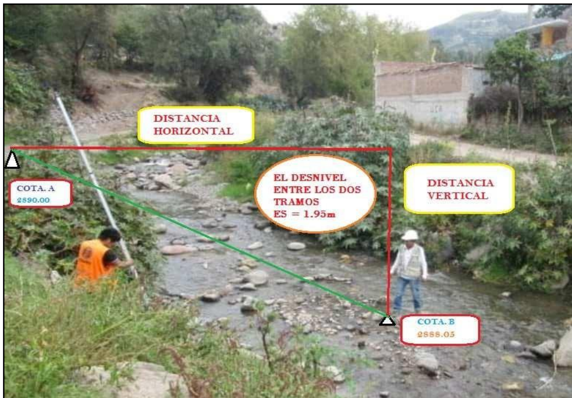
Figura 10. Estableciendo el desnivel de dos puntos.
