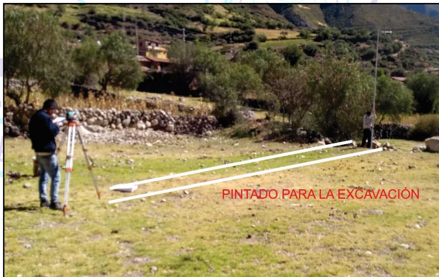
Figura 66.pintado del terreno a excavar.
