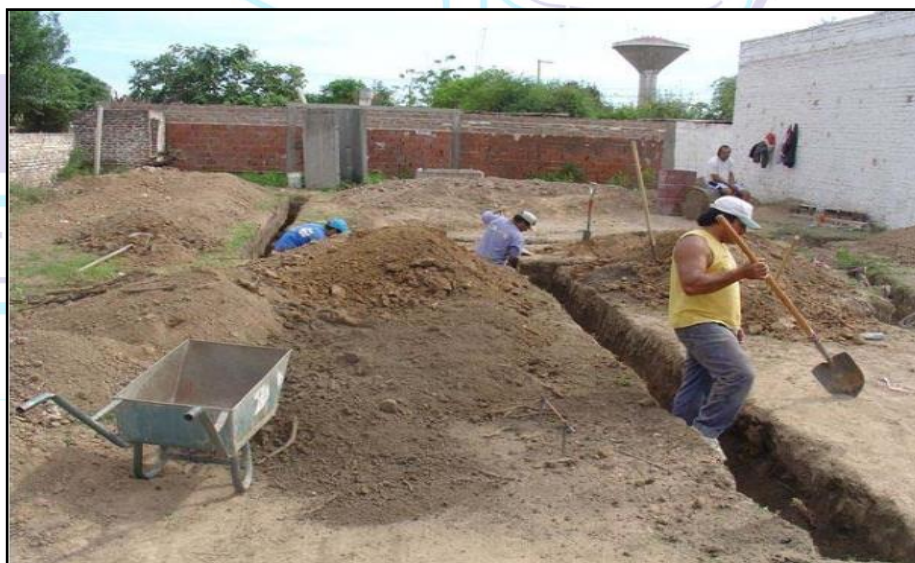
Figura 22. excavación de zanja.
