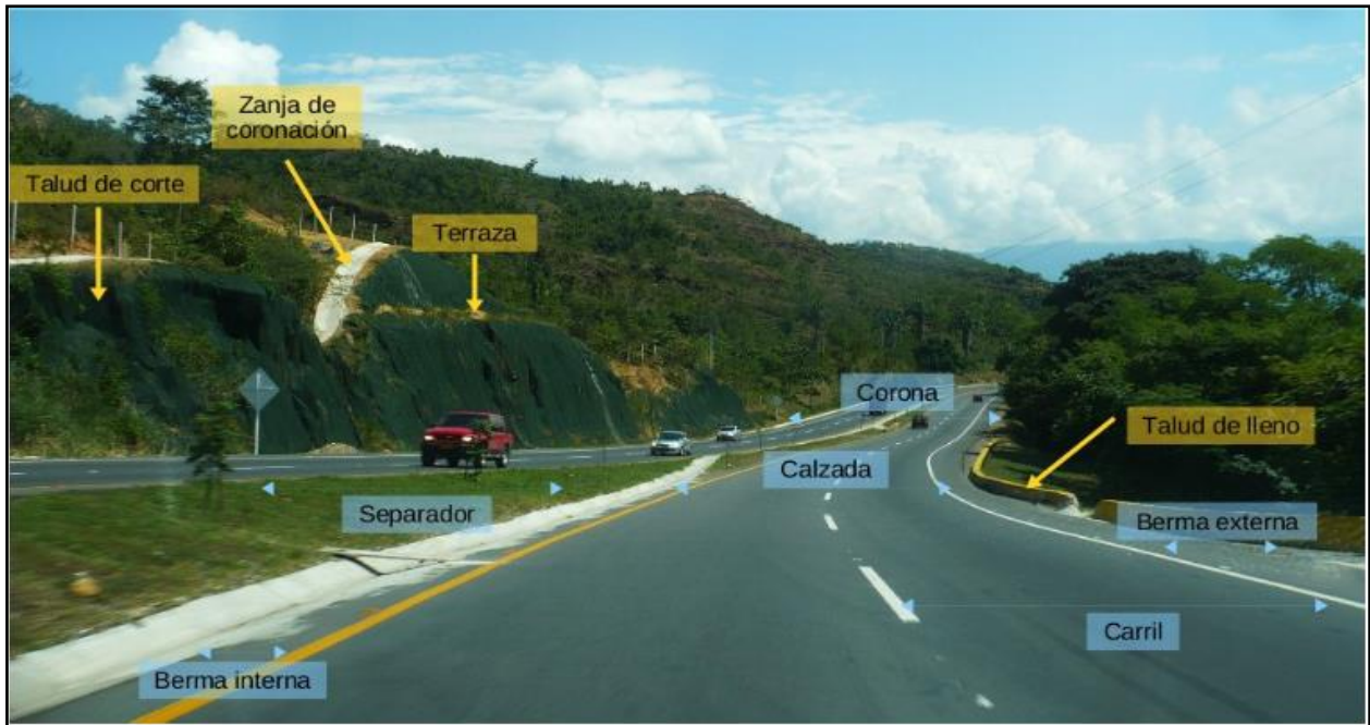
Figura 79 . elementos geométricos de una vía.
