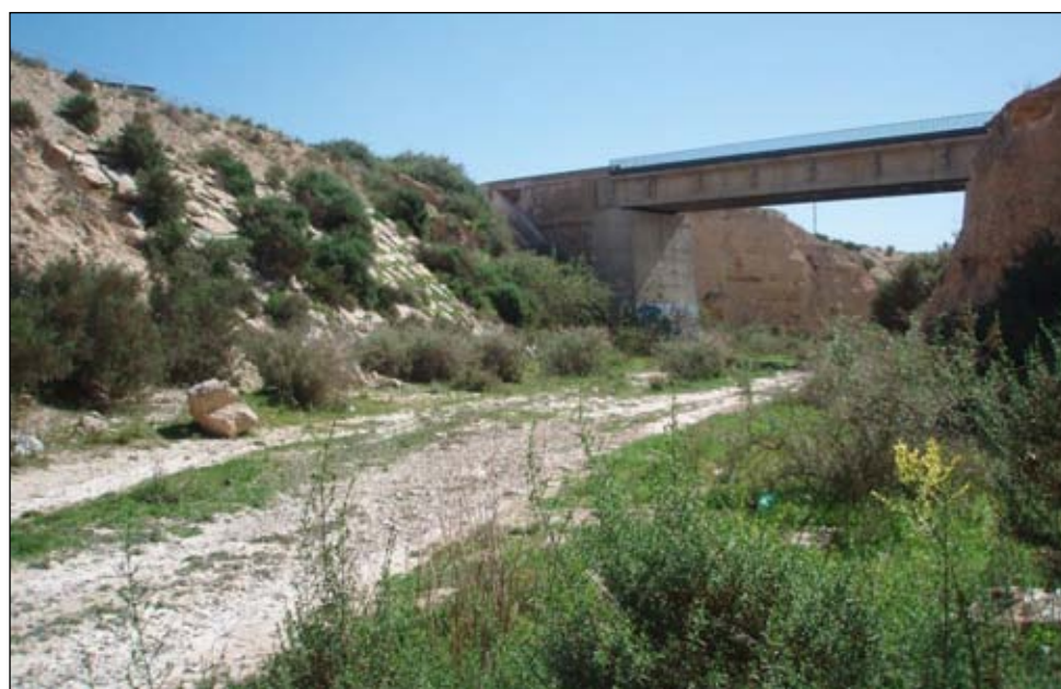
FIGURA 29. BCO. DES ARCS: ESTRUCTURA EXISTENTE.
