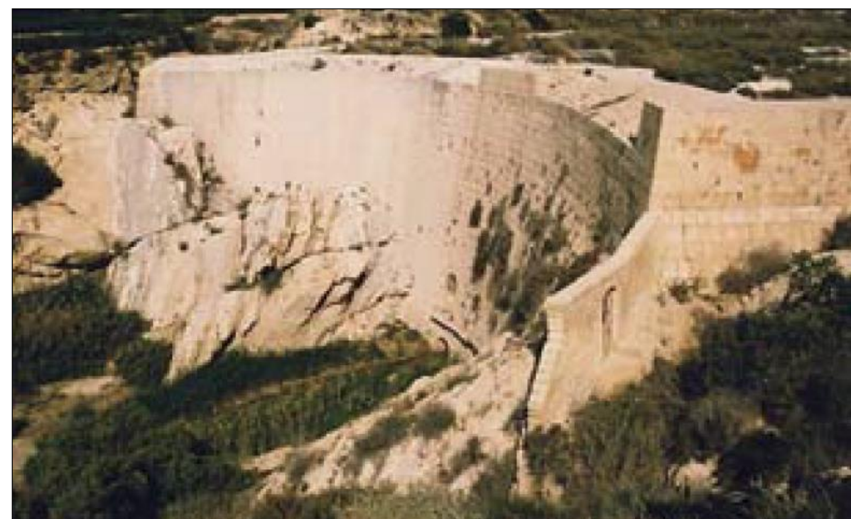
FIGURA 11. PRESA DE ELCHE
