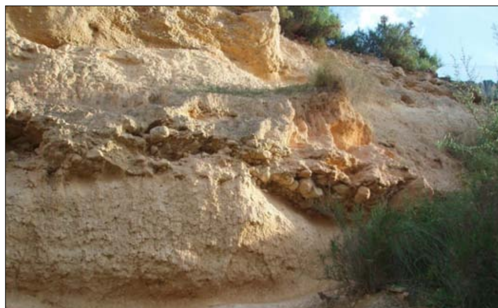
FIGURA 36. DESCALCE DEL ESCARPE EN MEANDRO.
