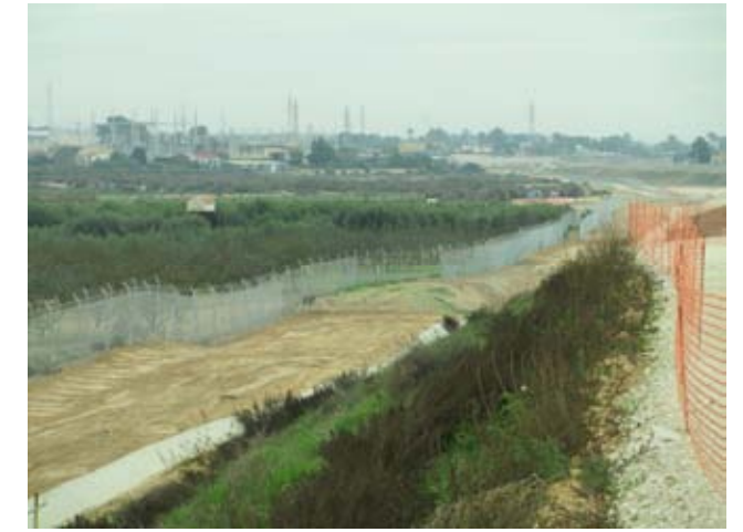
83 Panorámica PPKK 10+000-10+300: terraplén AVE sobre UG.1
