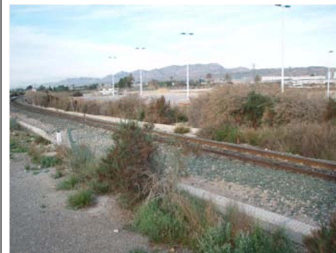
27 Zona de transición entre desmorte y terraplén de la vía existente a su paso por el Polígono Industrial al sur de Elche
