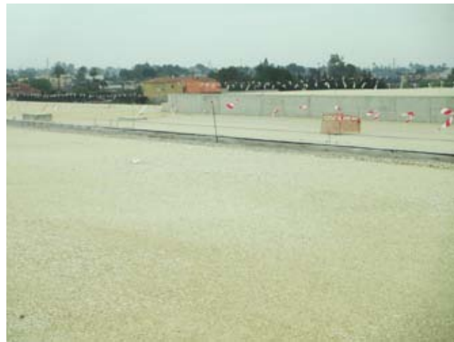
84 Futuros andenes estación AVE de Elche
