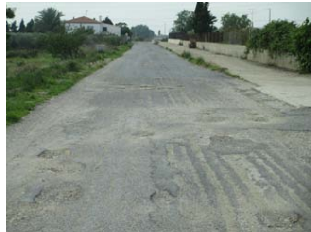
45 Vista PK 8+100: camino y canal
