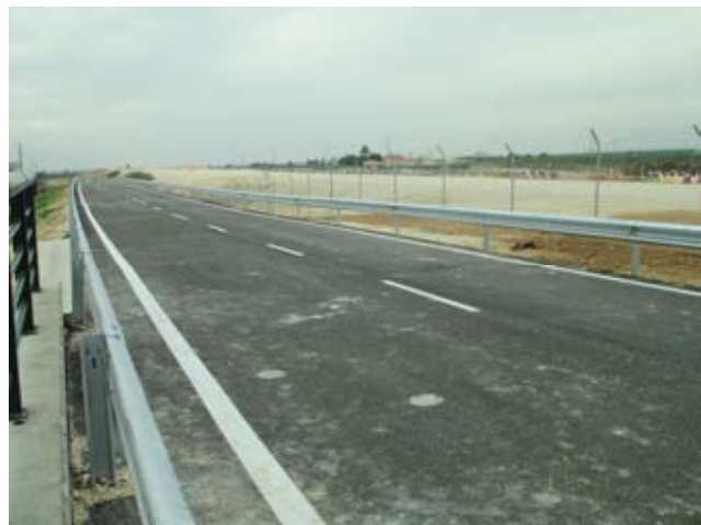
72 Camino de nueva construcción en PK 9+700-9+800 ramal sur.
