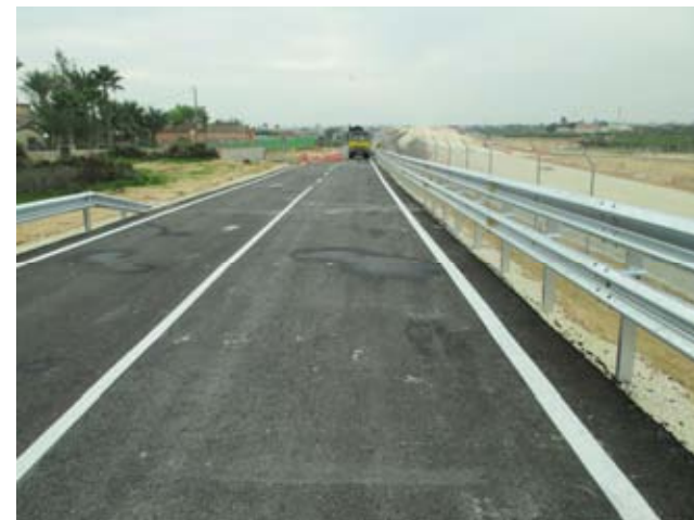
74 Camino de nueva construcción en PK 9+640 ramal norte.
