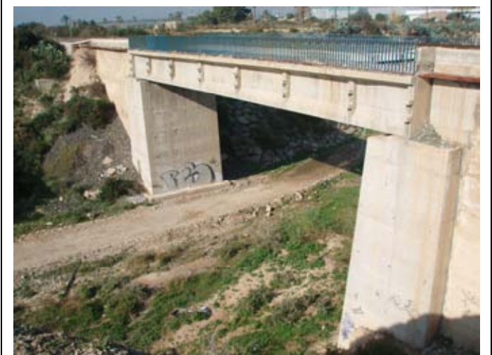
28 Viaducto del Barranco de Arcs/Monjas (PK 6+490).
