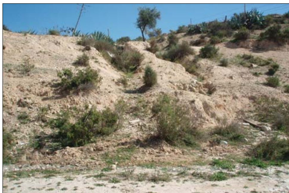
FIGURA 30. BCO. DES ARCS: ROTURA POR EVOLUCIÓN DE CÁRCAVAS.
