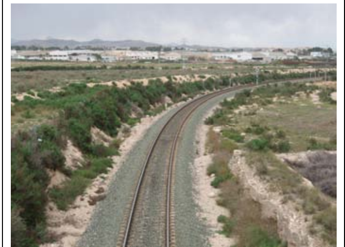
39 Panorámica del vertedero al norte de la vía, en la Plá de Sant Josep.
