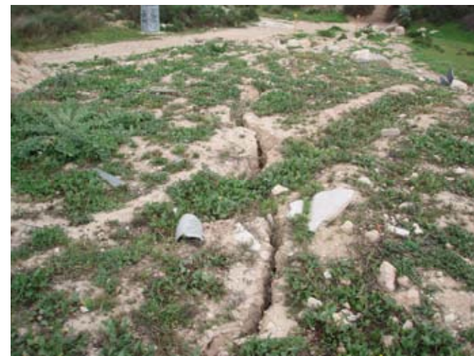
36 Grieta de colapso en los rellenos antrópicos sin compactar (UG.5) que forman el vertedero en la Plá de Sant Josep.
