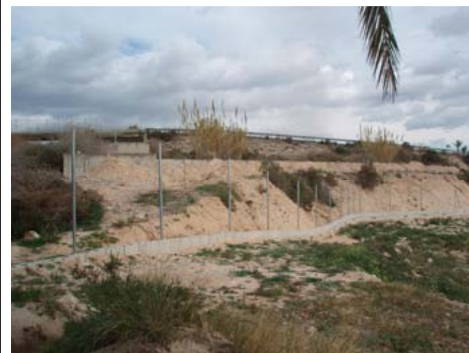
41 Canal de riego en el PK 7+820.
