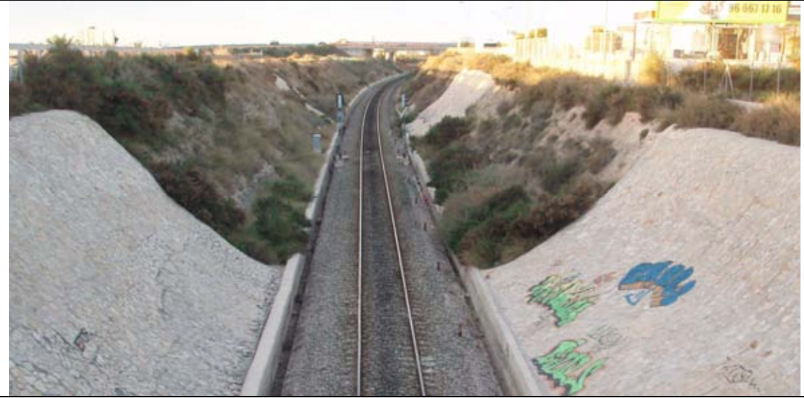
24 Vista de la boquilla de salida del túnel en la zona oeste de Elche (PK 5+480)
