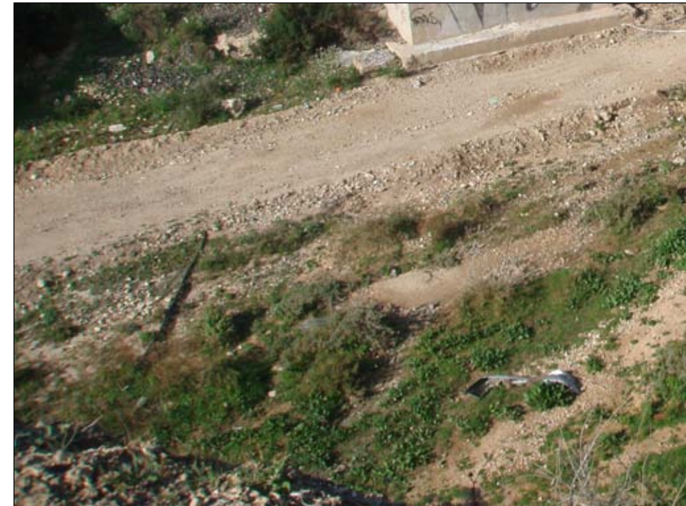
FIGURA 23. DEPÓSITOS DE FONDO DE CAUCE REMOVIDOS
