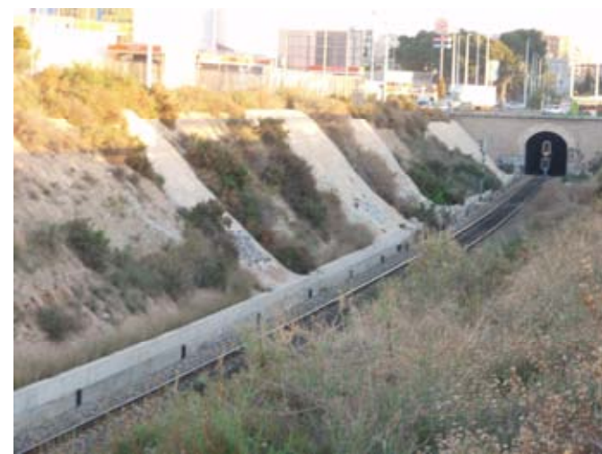
25 Desmorte en suelos aluviales (UG.1) con refuerzos de piedras hormigonadas (boquilla oeste del túnel de Elche).
