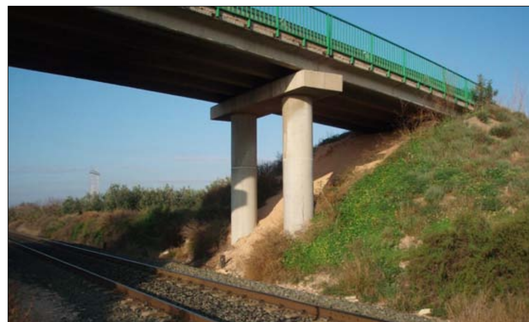
FIGURA 25. TERRAPLÉN FORMADO POR RELLENOS COMPACTADOS.
