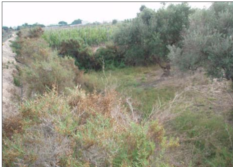
FIGURA 28. PUNTO BAJO GENERADO POR REBAJE DE PARCELA. PK 0+180
