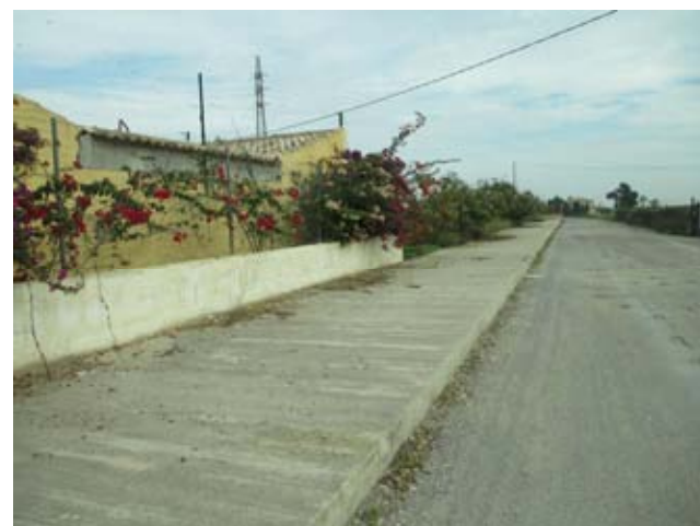
49 PK 8+420: afección a edificación
