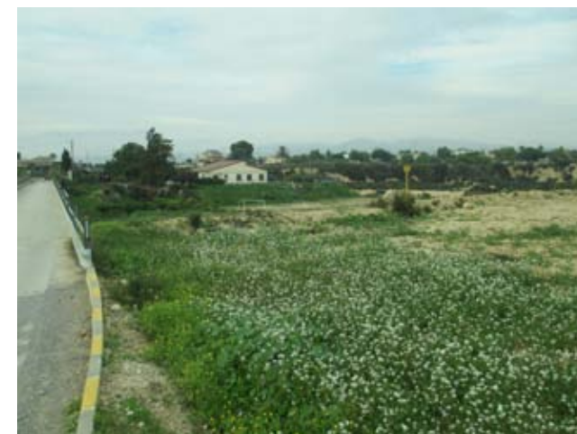
55 Zona estribo de la estructura sobre B.co Barbasena
