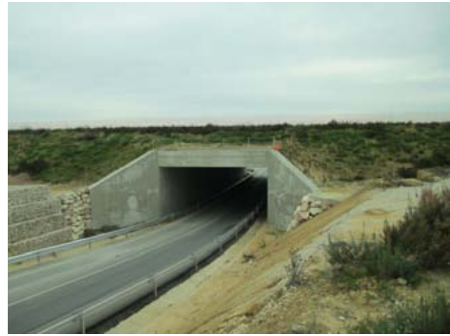
80 Paso inferior bajo plataforma AVE en zona de estación de Elche (PK 10+320 ramal norte)
