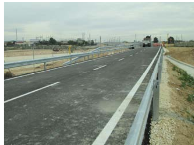
73 Camino de nueva construcción en PK 9+700 ramal sur.
