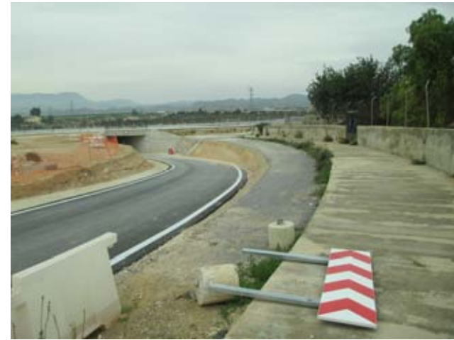
70 Camino y canal de riego en PK 9+730 ramal sur
