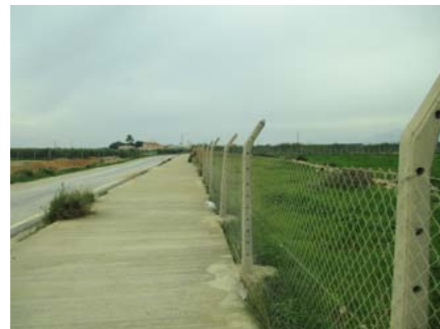
78 PK 10+000 ramal norte, paso por camino y canal de riego
