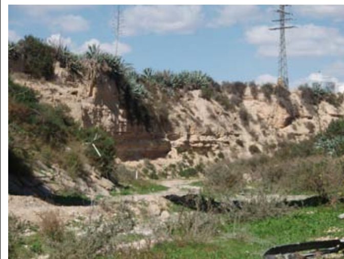
30 Escarpe en zona de meandro con fenómenos de regresión del talud por erosión en el pie (Barranco de Arcs/Monjas).
