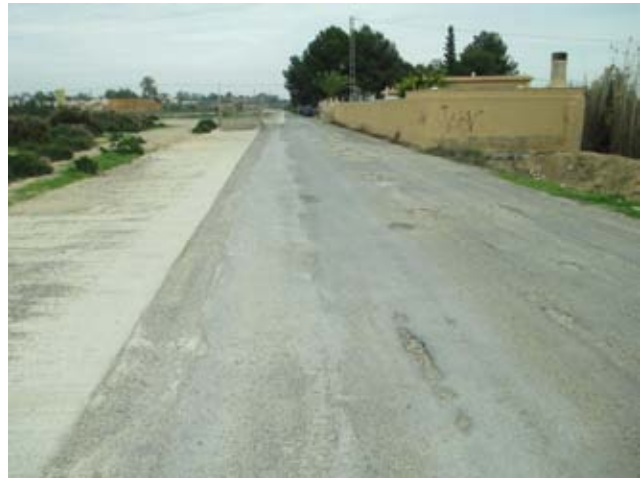
68 Canal de riego en PK 0+850 vial de reposición
