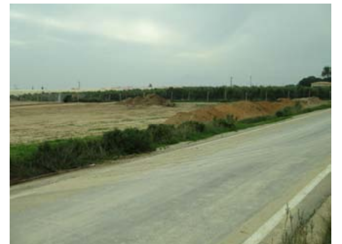
79 Vista del 10+000-10+100 del ramal norte
