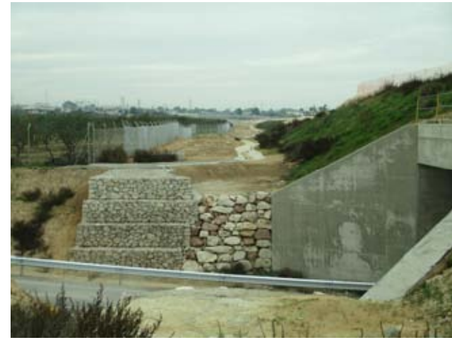
81 Drenaje plataforma AVE en PK 10+200-10+300
