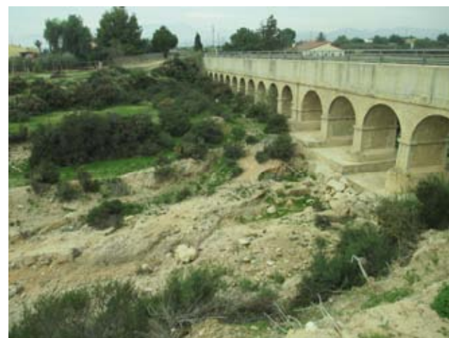
53 Barranco Barbasena en OK 8+750: canal de riego
