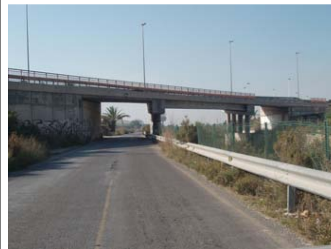
26 Paso superior en el PK 5+880 (carretera CV-84).
