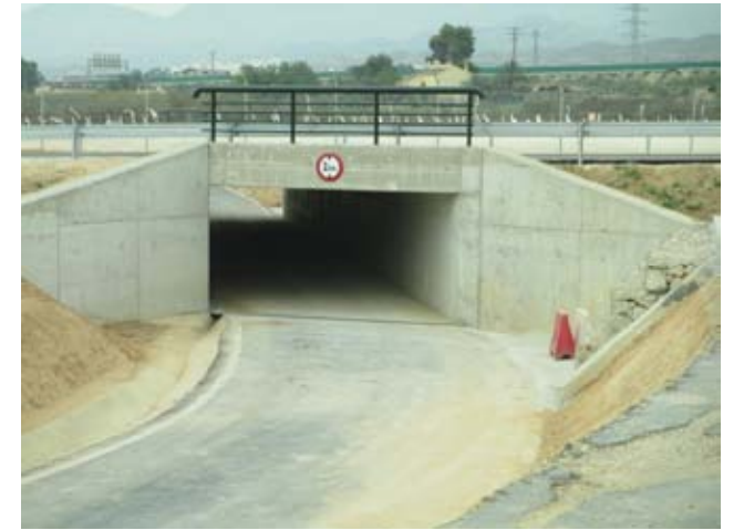
71 Paso inferior del camino y canal de riego bajo plataforma AVE.
