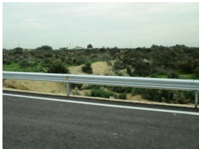
76 Vista PK 9+600 ramal norte en suelos aluviales limosos
