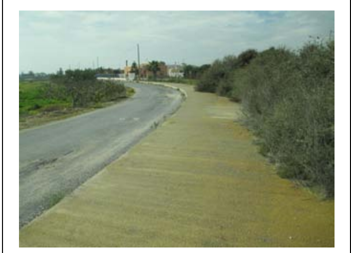
43 Canal de riego en PK 7+900
