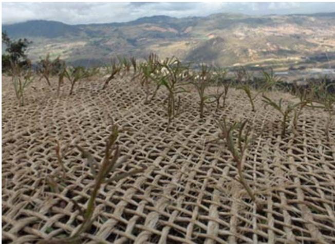
**Agrotexil:** Compuesto de un tejido de fibra corta punzonado como un fieltro que puede estar reforzado con una malla de fibra o de polipropileno, en uno u otro caso están sustentados por conceptos de biodegradabilidad o fotodegradabilidad y que tanto impacto pueden producir, en el caso de mallas plásticas que a pesar de ser temporales tengan la durabilidad necesaria para que crezca la vegetación, que duren de 1 a 2 años.
