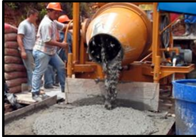
Figura 2.21 Obrero elaborando concreto mediante una concreteira.
