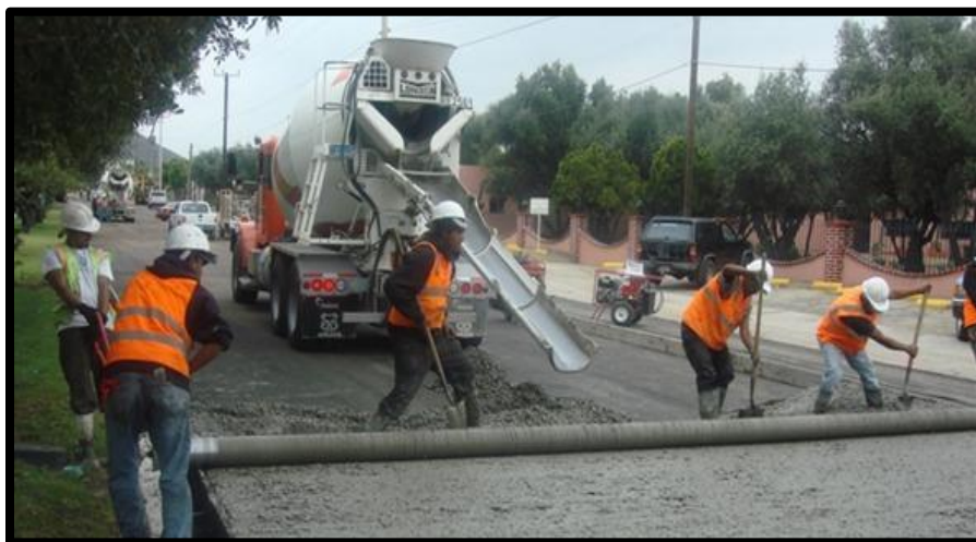
Figura 2.20 Colocación de concreto en estado fresco.
