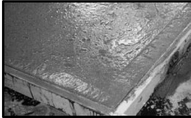
Figura 2.23 Agua de sangrado en la superficie de una losa.
