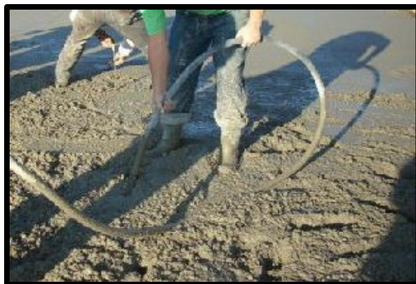
Figura 2.24 Vibrado del concreto en obra.
