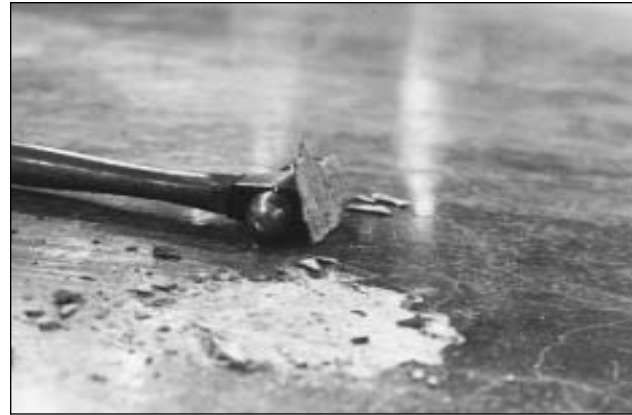
Concreto delaminado
